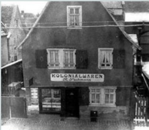
Wohnhaus und Laden von Mina Nachmann, Marktstraße 72 Foto: Helmut Ullshöfer (Autor der ursprünglichen Fassung der hier überarbeiteten Ausstellung)
