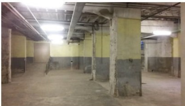
Kellergeschoß der Erinnerungsstätte Großmarkthalle Frankfurt am Main Foto: 2017 Ewald Wirth
