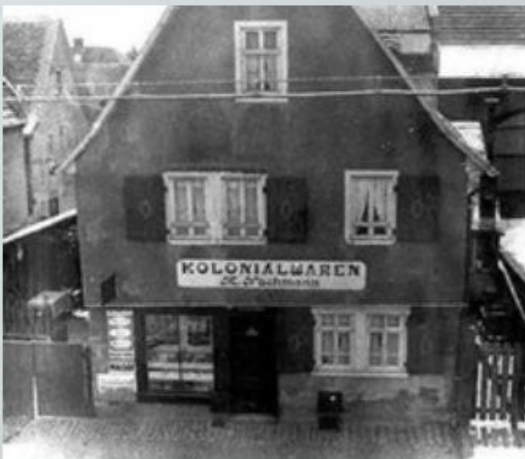
Wohnhaus und Laden von Mina Nachmann, Marktstraße 72 Foto: Helmut Ulshöfer (Autor der ursprünglichen Fassung der hier überarbeiteten Ausstellung)
