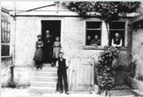
Alte Synagoge in der Rathausgasse Foto: 1912/13 Courtesy Leo Baeck Institute, New York Courtesy of the Leo Baeck Institute, New York, 10.01.2021. Mit freundlicher Genehmigung des Leo Beck Instituts, New York.
